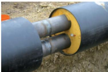
Dem Transport der Wärme wird auch eine große Rolle zuteil. So ist es wichtig, dass die Rohrleitungen ausreichend gedämmt sind, damit so wenig Wärme wie möglich beim Transport verloren geht.
