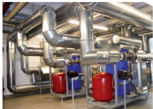
Bild 4: Fernwärmeübergabestation 1.400 kW zur Versorgung eines Krankenhauses
