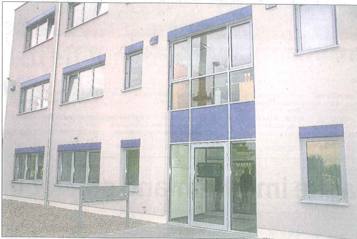
Fertiggestellt wurde das neue Verwaltungsgebäude der Firma Ebero in Pulheim. (Foto: Wolf)
